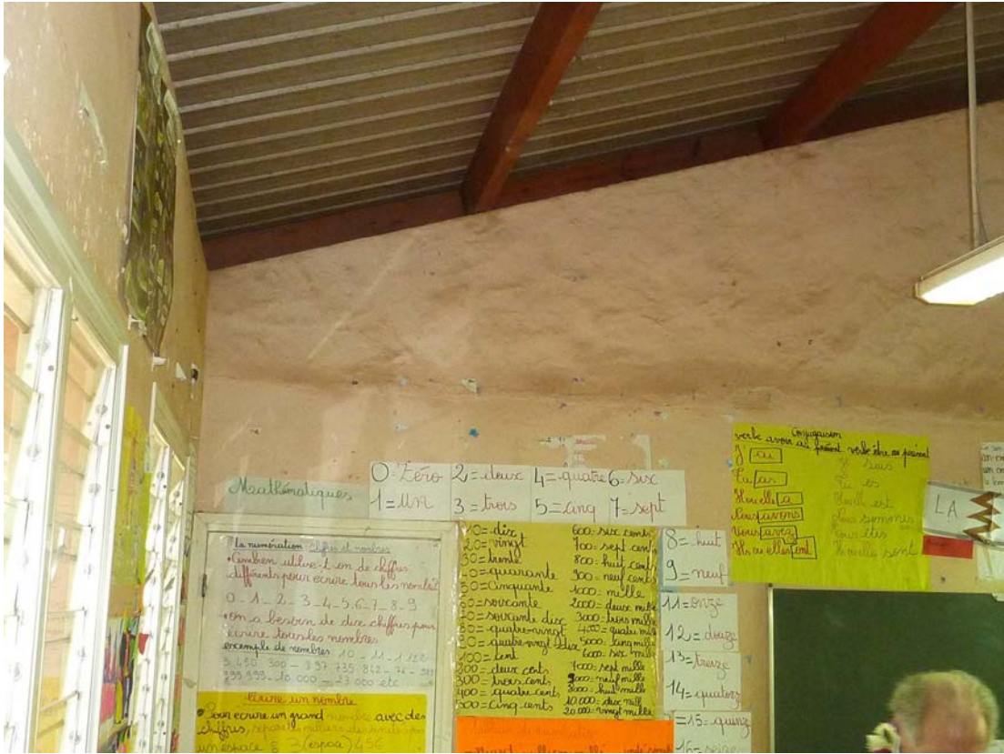
L'impact de l'humidité sur les murs
