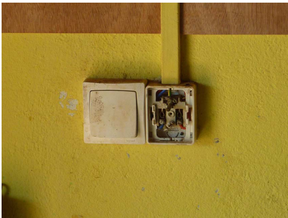
Détail d'un interrupteur électrique dans une classe.
