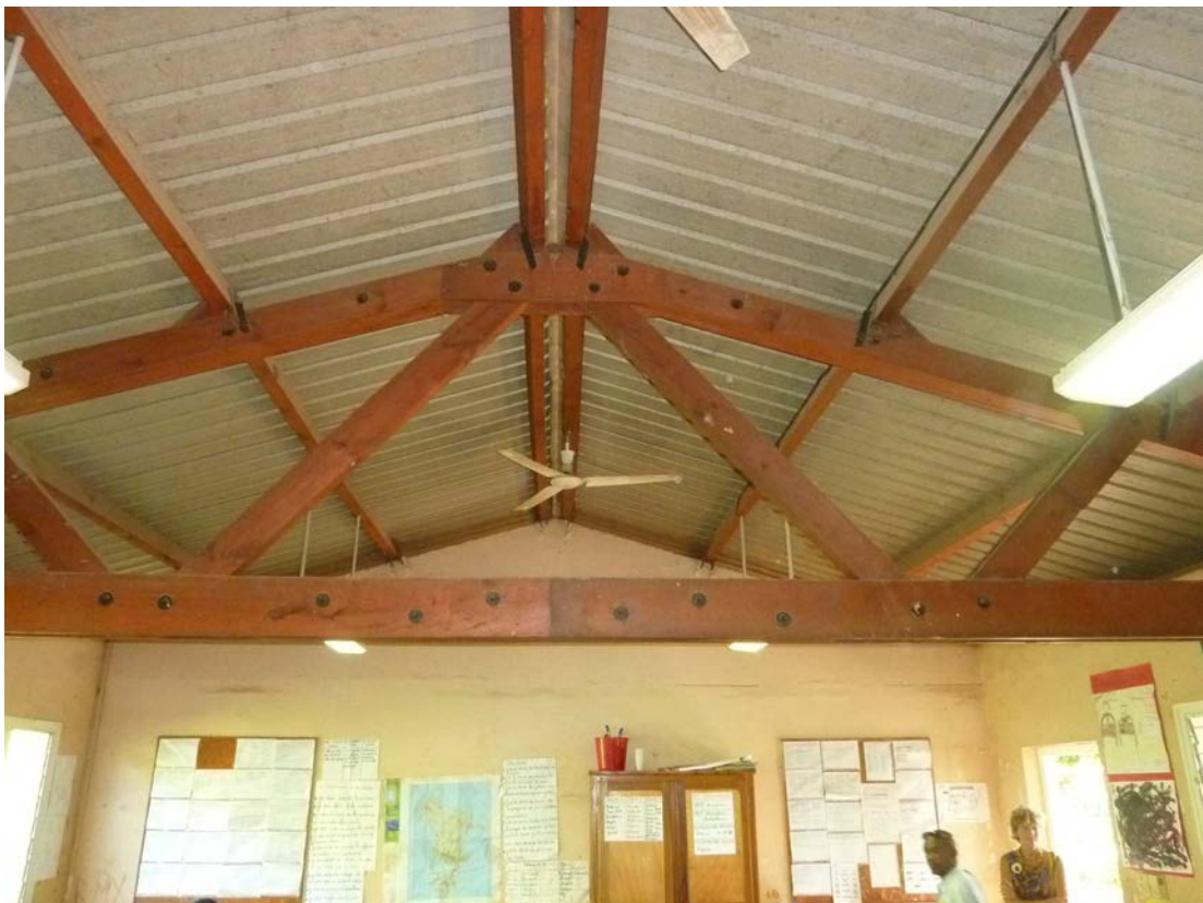
Aucune isolation thermique, les brasseurs d'air sont situés trop haut pour aérer.
