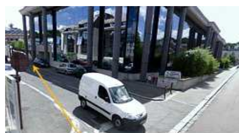
accès C.I.O. au fond de l'impasse
