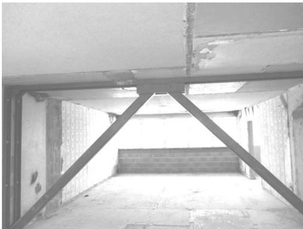
*fig. 11 : palée de stabilité métallique en forme de K dans la trame adjacente au voile n°5*
