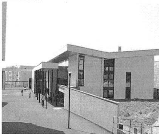
Lycée Oehmichen à Châlons-en-Champagne: le nouveau CDI au sein du pôle vie scolaire à l'entrée du lycée (2004)
