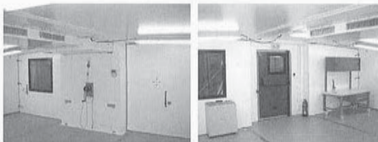
Figure 5 : shelter double déployable 20 pieds
