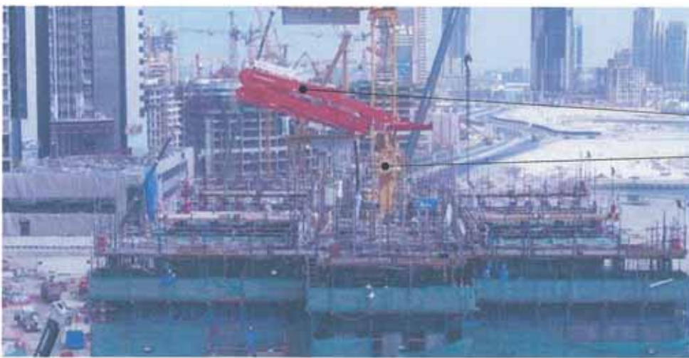
Flèche articulée de distribution Colonne d'alimentation en béton
