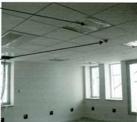
Les détecteurs THERMOKON MDS Standard type S1 utilisés assurent la détection présence et la détection de lumière.
