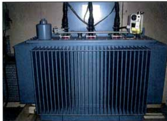
Transformateur HTA/BTA (TR2).
