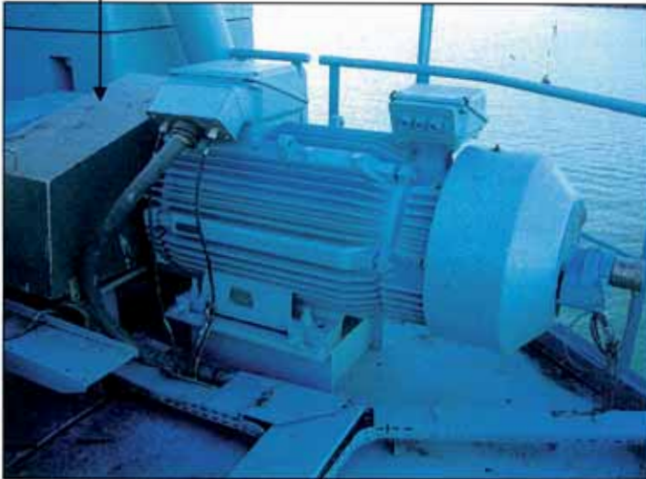
Moteur de relevage et frein service.
