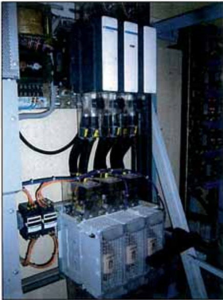
Sortie du transformateur triphasé.
