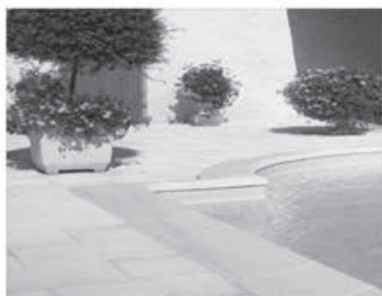
Margelles de piscine
