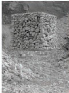
■ Panneaux électrosoudés en Galfan® spécial garantissant une protection exceptionnelle contre la corrosion (8 à 10 fois plus que la galvanisation).
