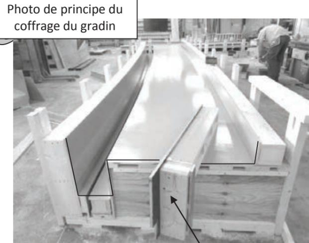
About permettant de fermer l'extrémité du moule
