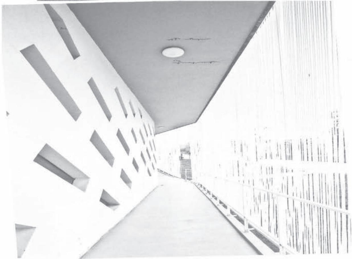
Un voile de fils de nylon de 8mm de diamètre crée de l'intimité avec l'extérieur.
