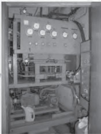
Pour un bon fonctionnement de cet équipement, et de façon à respecter la viscosité de l'huile, il est nécessaire de contrôler la température de cette dernière qui doit être maintenue entre 10 et 40°C. On rappelle que la température extérieure à cette altitude peut varier de -30 à 20°C durant une période d'observation. Il y a donc une phase de préparation avant chaque campagne d'observation.
