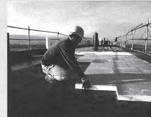
Pose libre des panneaux Knauf Thane ET sur le pare-vapeur.
