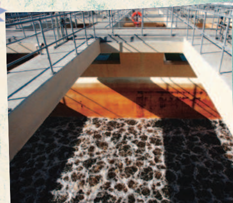
Station de désalinisation à Palmahim (au sud de Tel-Aviv, Israël)
