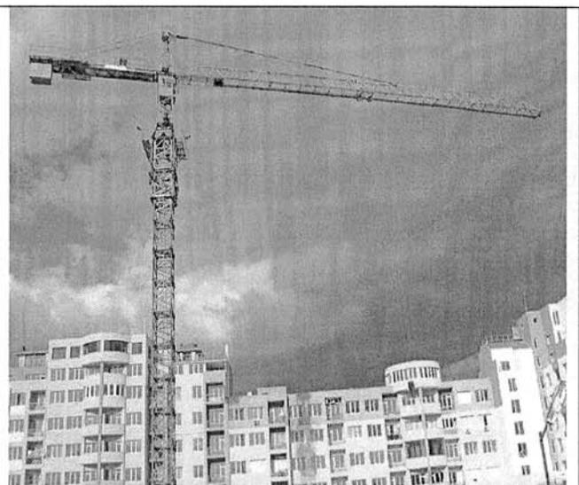
**Figure 2** Grue à tour ou grue de chantier
